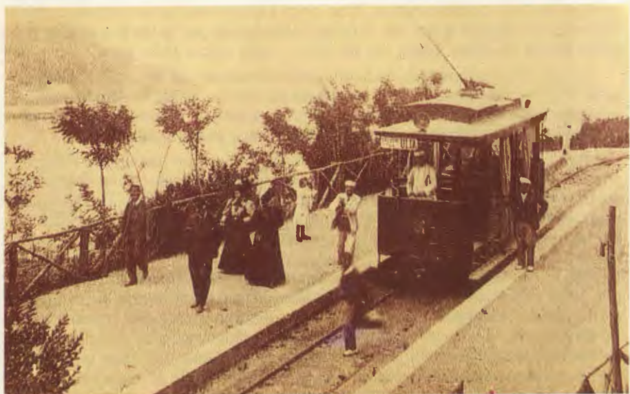
Vista de la terminal del Monte Ulía.
