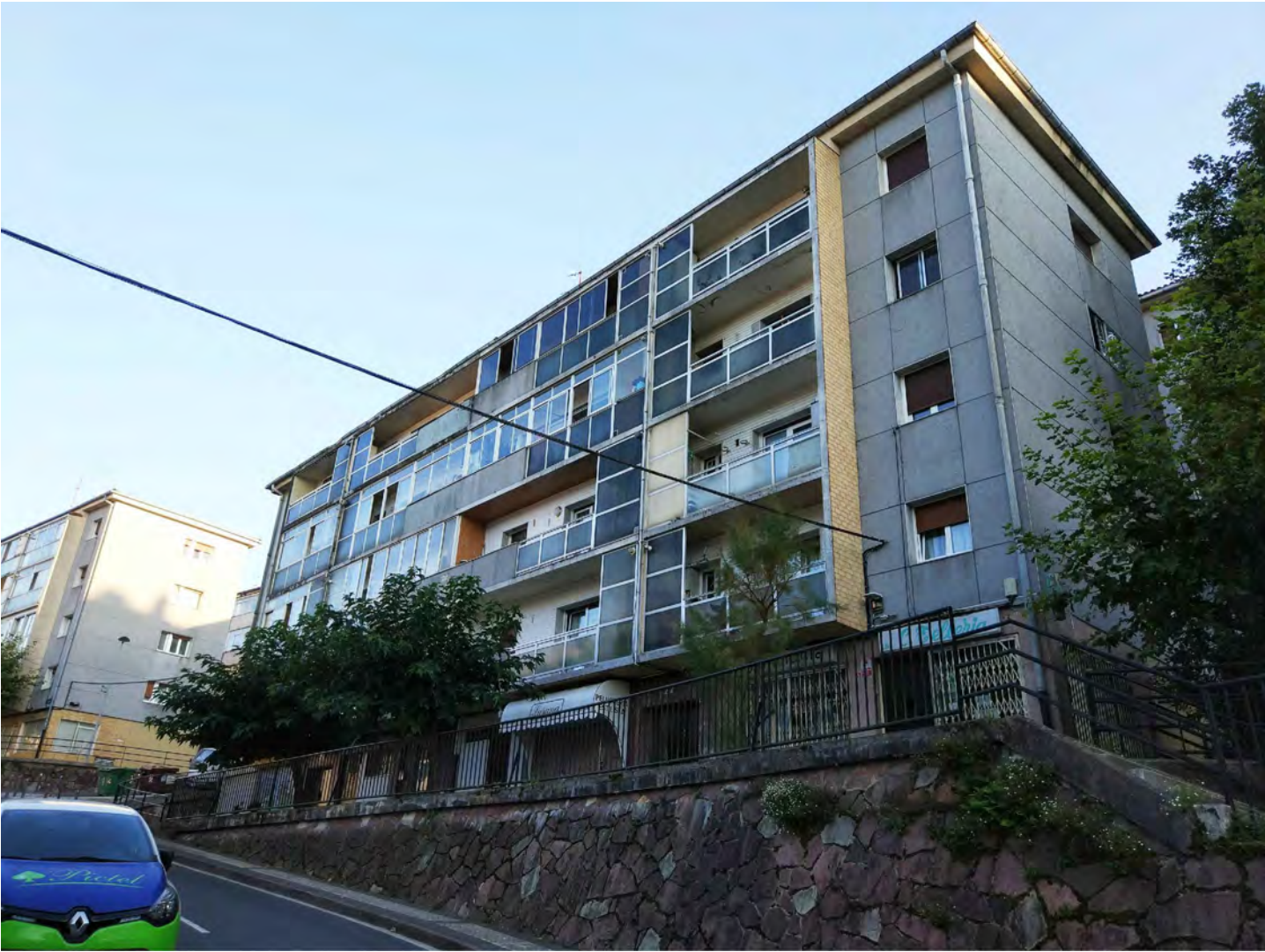
VISTA 1 ESTADO ACTUAL
