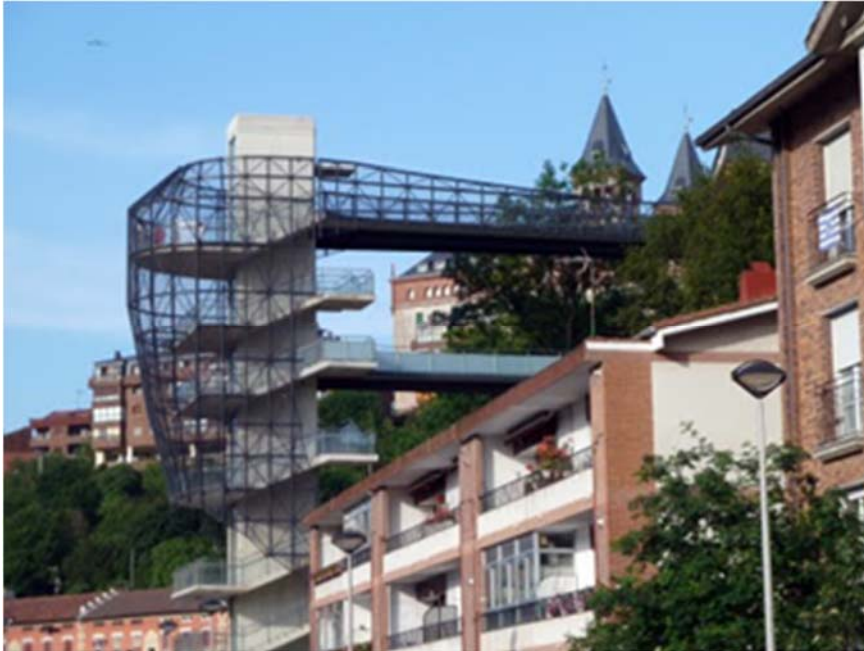
Ascensor de la c/ Aizgorri (Barrio Antiguo-Ayete)
