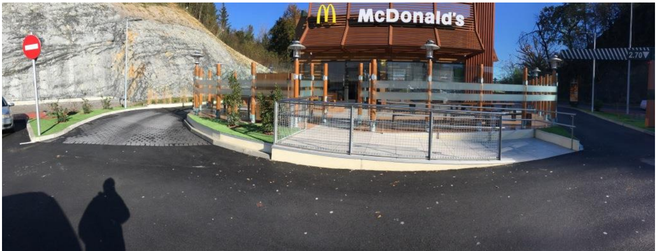
Fotografía 01. Zona de acceso principal.
