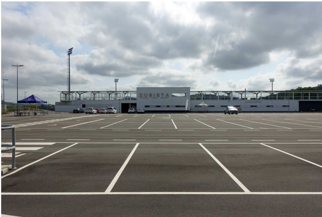
Vista del estado actual del edificio IZAN y del aparcamiento
