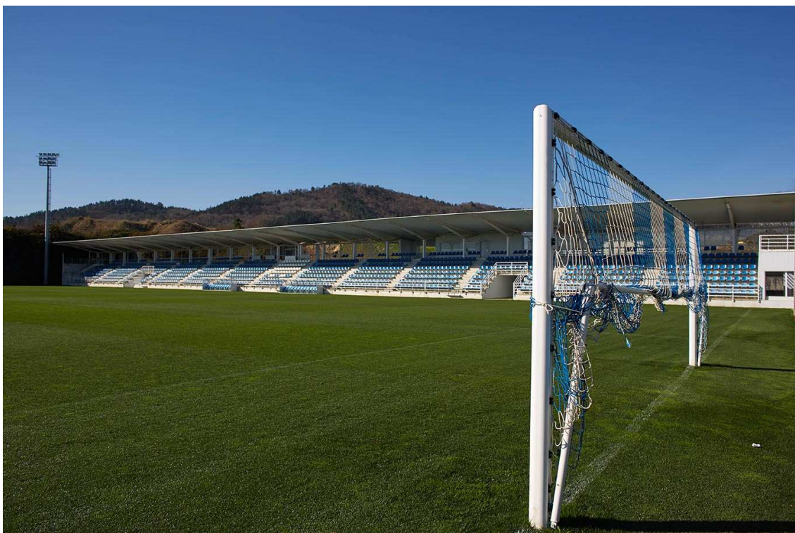
Vista del estado actual del edificio IZAN de la grada
