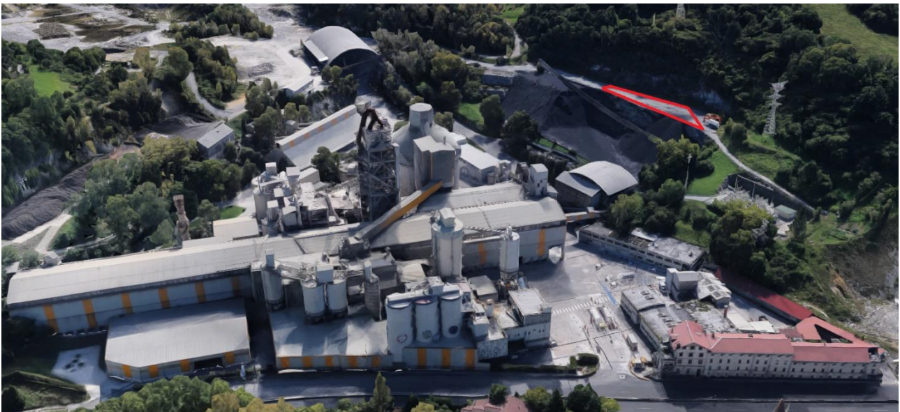
2. irudia Zementu-fabrika airetik ikustea, instalazio berriaren ezarpena identifikatuz (gorriz).
