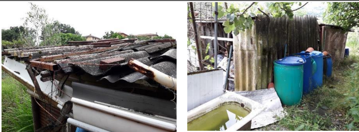
Figura 5. Inspección visual del emplazamiento
