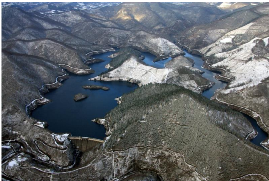
Figura 3. Vista general del embalse y de la presa de Añarbe.
