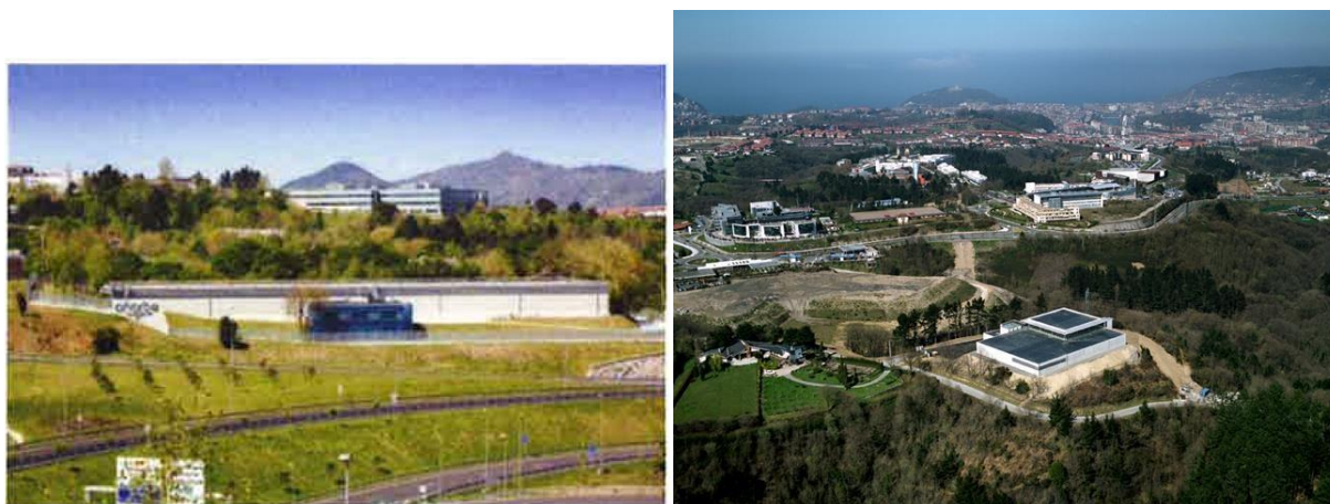
Figura 8. Vista aérea del DDAP Amara (izquierda) y del DDAP Oriaventa (derecha), en San Sebastián.
