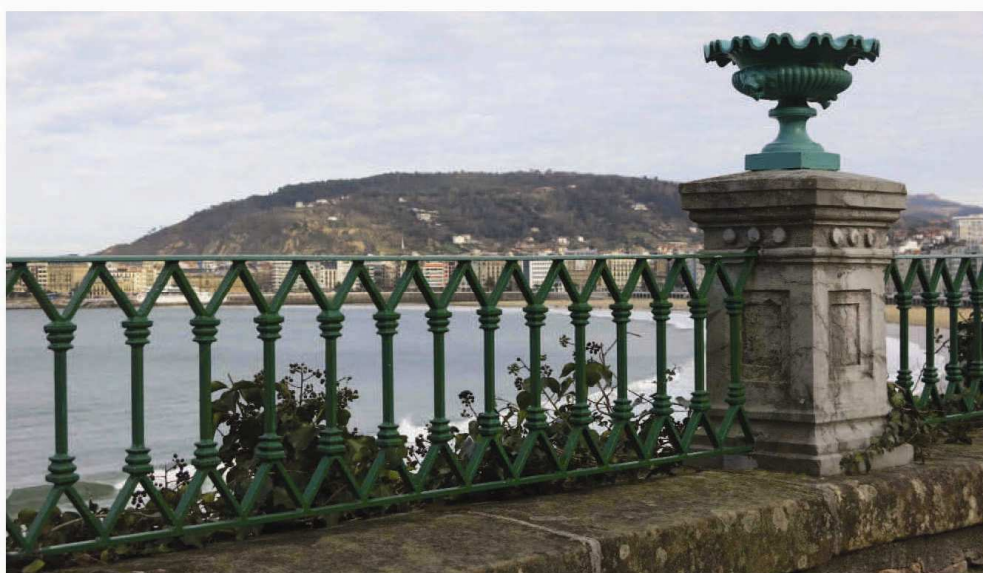
2.- Baranda (Mirakontxa Pasealekua)
