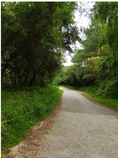
Hormigoitik asfalturako aldaketa, Las Camelias baino lehen.
