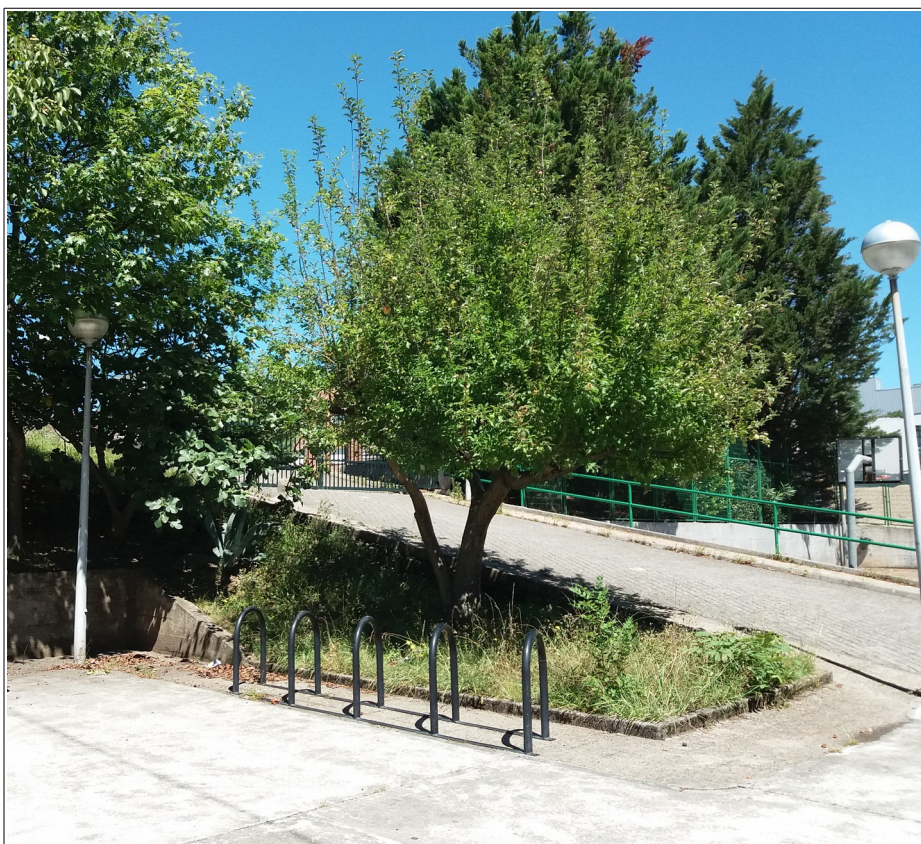
Área 3: rampa de acceso
