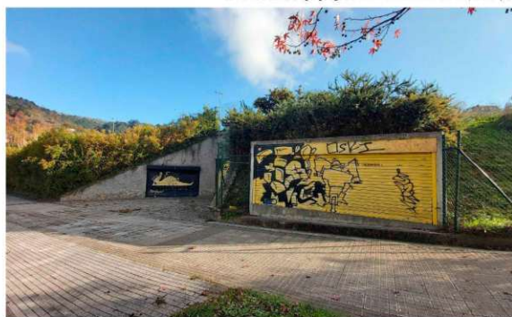
04. Partzela azpiko ekialtz tankerako sarrera. Entrada al tanque de retención de tormentas ubicado bajo la parcela. (2021)
