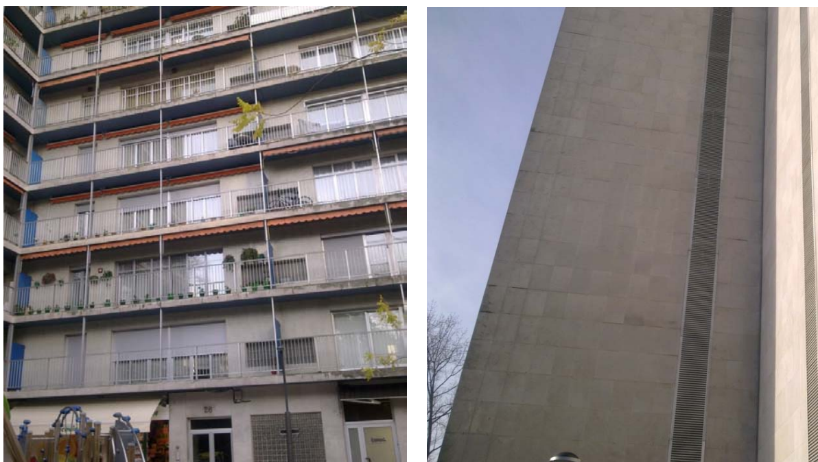
Figura 4.- Portal 26. Izquierda: fachada oeste. Derecha: fachadas norte opaca
