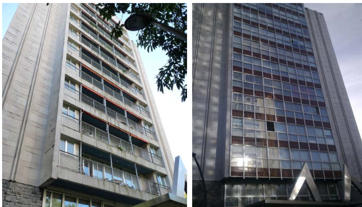
Figura 3.- Izquierda: fachada oeste portal 7. Derecha: fachadas oeste portal 5
