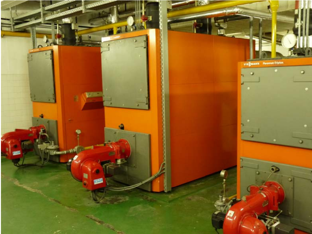
Figura 1. Equipos de generador de calor del sistema de distrito Fuente: CENER
