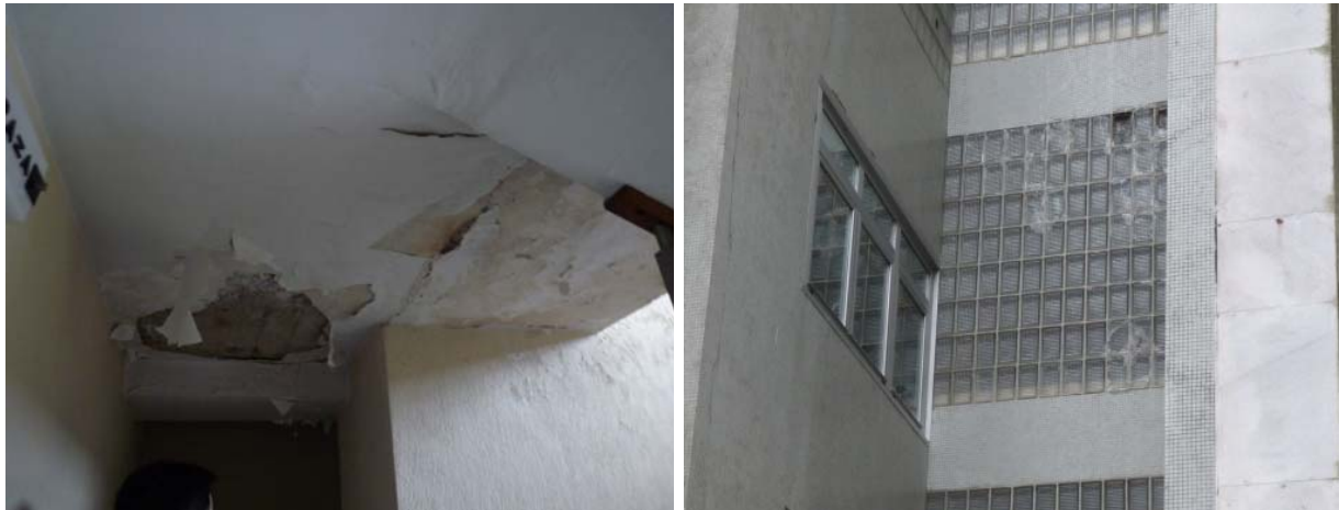
Figura 6. Detalles humedad bajo-cubierta. Desperfectos en fachada norte
