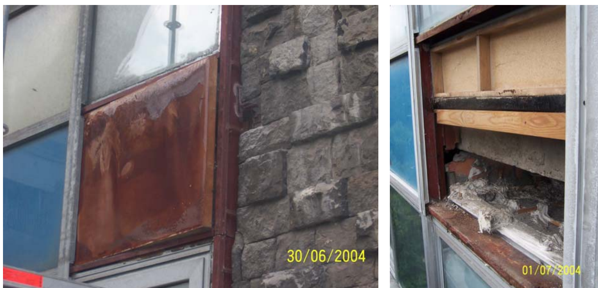
Figura 6. Detalles muro cortina (frente de forjado) Fuente: TEUSA
