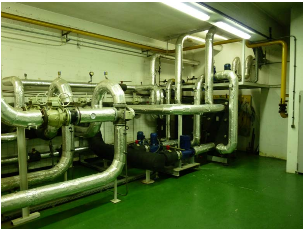
Figura 2. Equipos hidráulicos de la central de de generación de calor Fuente: CENER
