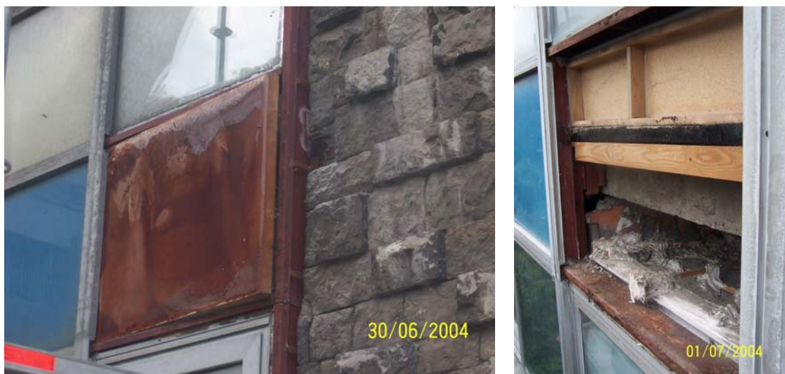
Figura 7.- Detalles muro cortina (frente de forjado)
