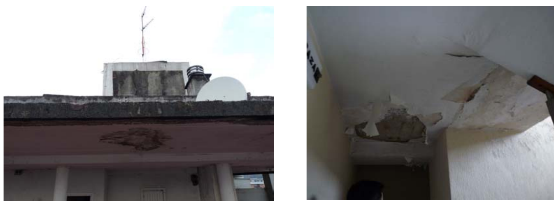
Figura 5.- Detalles para determinar el forjado unidireccional de hormigón armado
