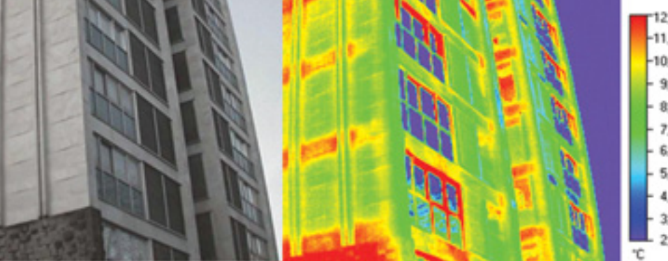
Azterketa termografikoak. Bidebieta I
