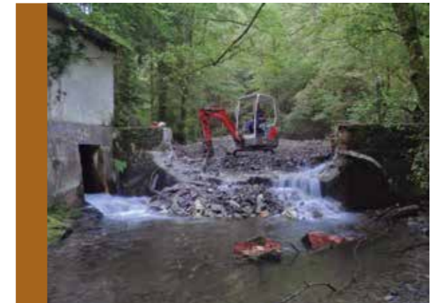
Derribando el azud de Urdallue. Autor: Iñaki Uranga
