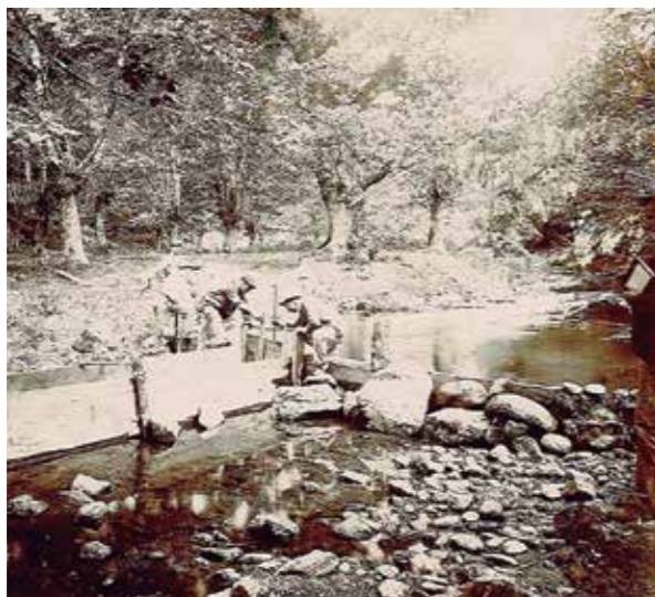
Construcción de la presa en Sasiandú (río Elama) hacia 1903. Fuente: Archivo municipal
