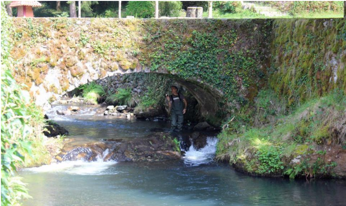
Revisión de las grietas de puentes
