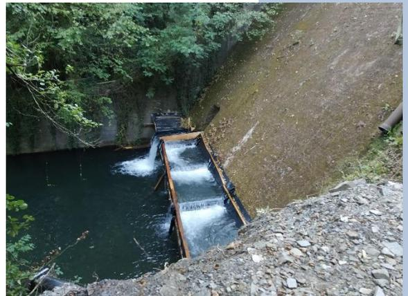
Rampe provisoire qui facilite le mouvement des poissons en amont.
