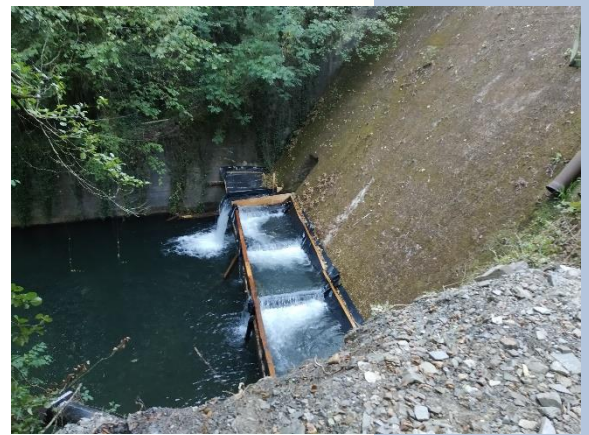
Rampa provisional que facilita el movimiento de los peces aguas arriba.
