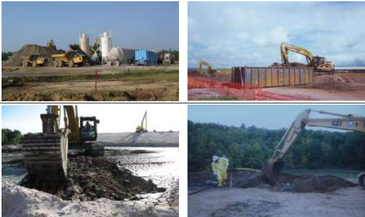
Figura 11. Solidificación/estabilización on site e in situ
