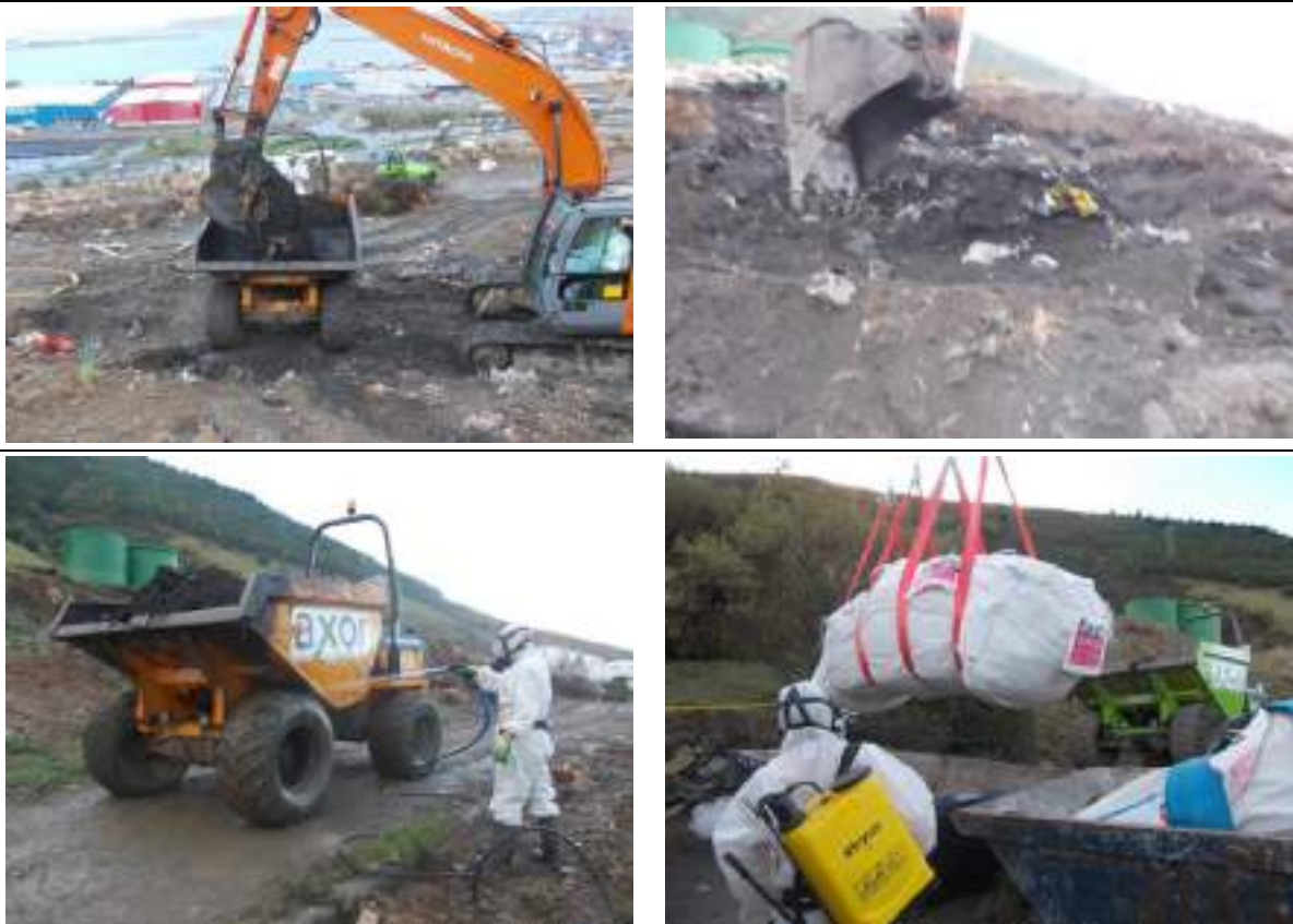
Figura 10. Excavación selectiva de tierras con amianto
