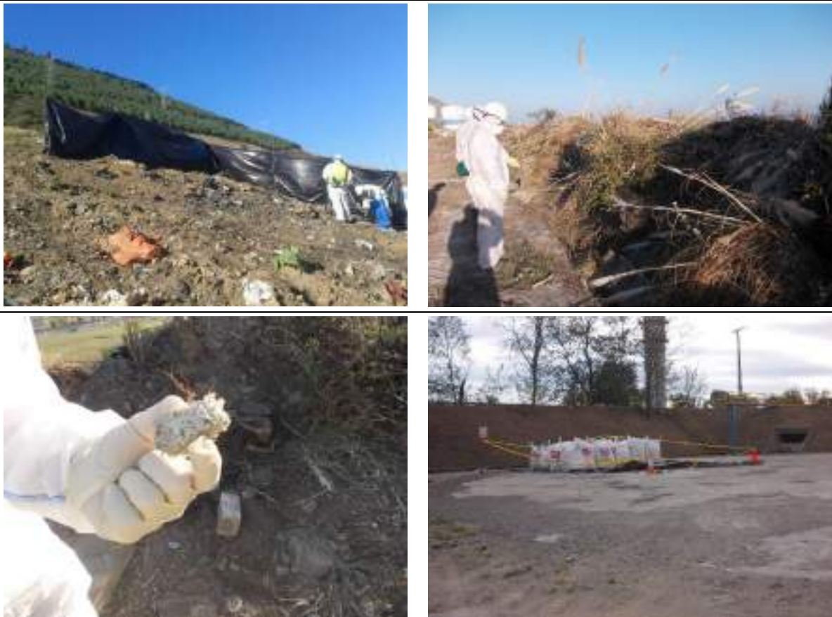
Figura 9. Recogida manual de amianto
