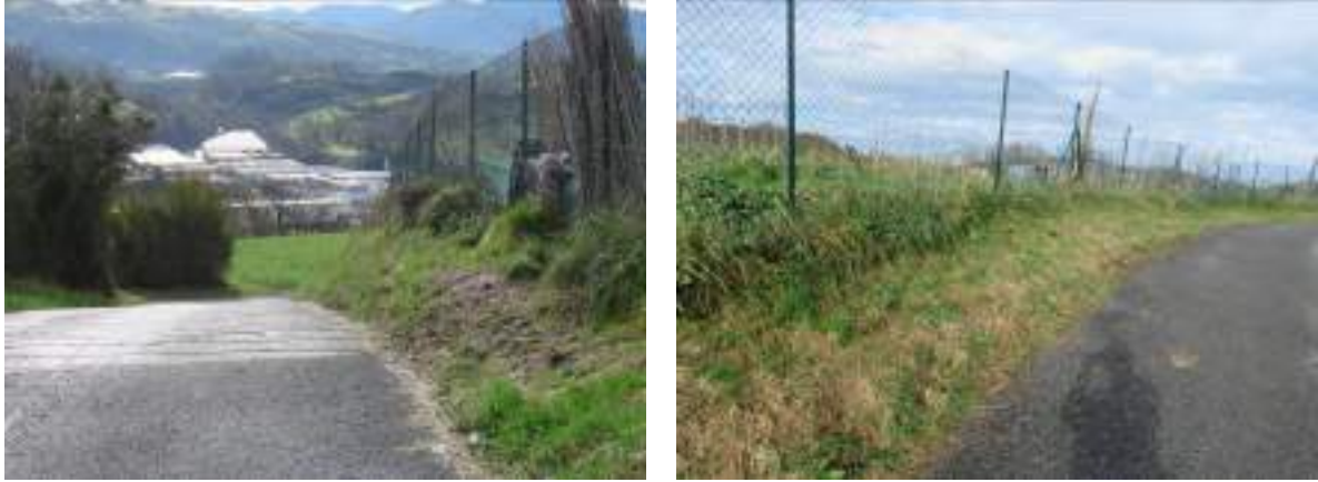
Talud existente en parte del margen de Marrus Bidea
