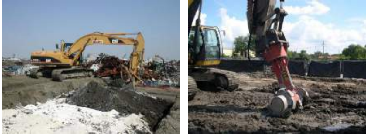
Figura 11. Solidificación/estabilización on site e in situ
