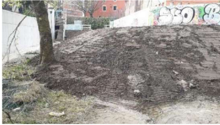
Figura 4. Estado actual del emplazamiento
