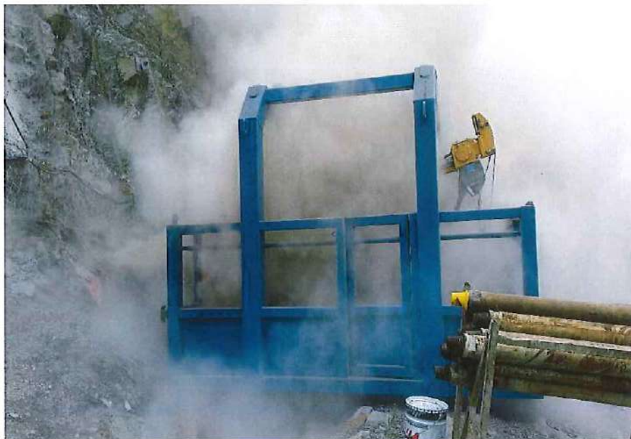
Jaula empleada tanto para ejecución de anclajes como para la ejecución del hormigón proyectado
