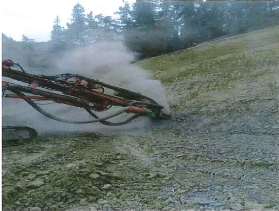
Equipo de perforación
