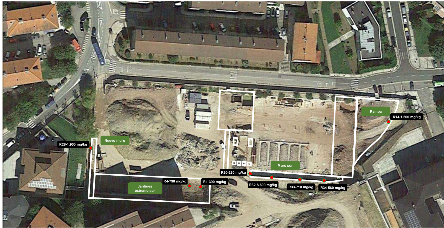
Figura 2. Áreas excavadas y superaciones de la concentración de referencia para amianto
