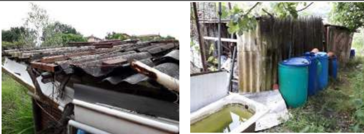
Figura 5. Inspección visual del emplazamiento
