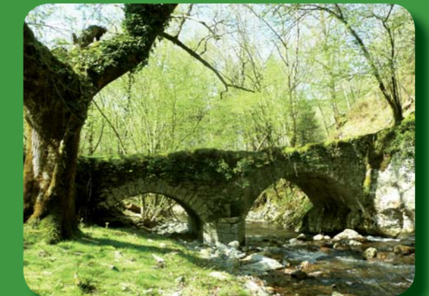
Goizaringo zubia/Puente de Goizarin/Pont de Goizarin
