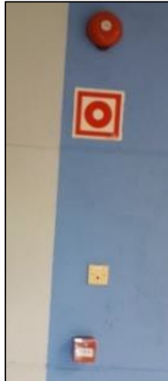
Sakagailua eta sirena
