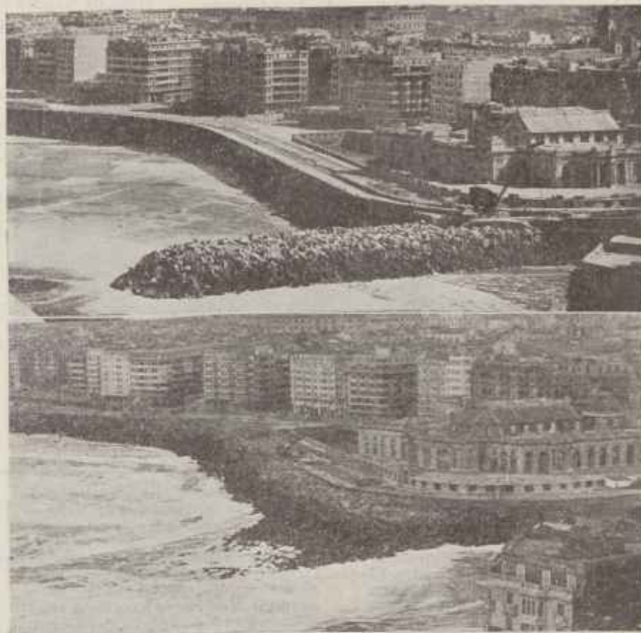
En estas dos fotografías podemos comprobar, (en la de arriba) lo que se llegó a avanzar en la formación del espigón del Gran Kursaal, y (en la de abajo) cómo ha sido luego casi totalmente absorbido y aniquilado por el mar. (Fotos, Schneidhofer y Willy Koch.)
