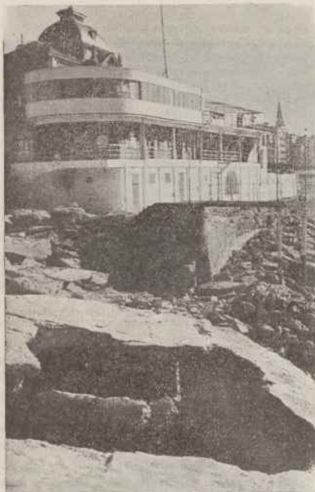
Con ocasión de un furioso temporal las olas causaron estos destrozos y sacavones en los alrededores del edificio del Club Náutico que dió inequívoco testimonio de la enorme resistencia de sus sólidos cimientos y defensas.
