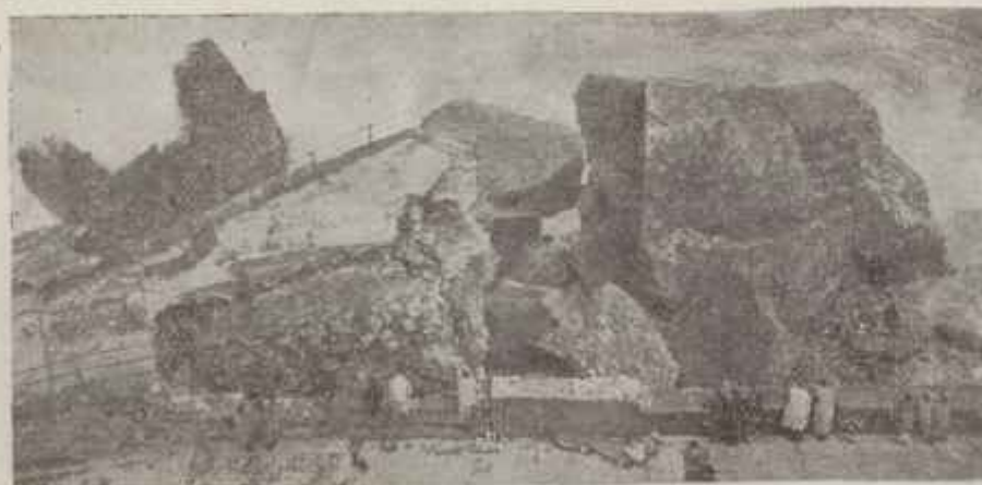
Aquel mirador de la Zurriola, llamado «rompeolas» fué paulatinamente desmoronado por las olas en la forma que el grabado muestra. Ya no quedan de él ni estos descomunales escombros que luego se han ido desmenuzando y desapareciendo. Ya no queda nada del «rompeolas»...
