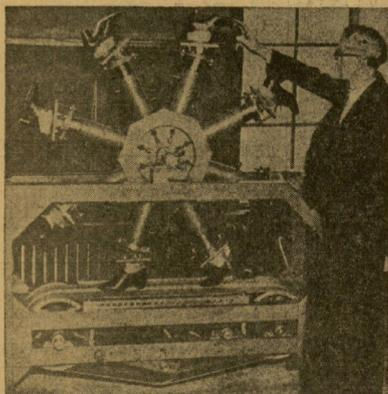
Máquina inventada para conocer la duración de los calzados. Cada zapato, al pisar sobre la correa, acusa exactamente el desgaste ocasionado por un paso de persona.
