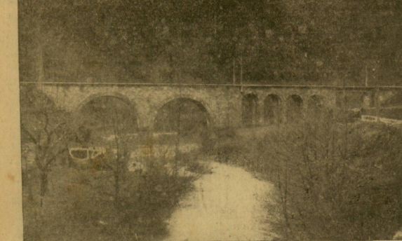
Puente entre Azcoitia y Zumarraga: tramo de hormigón armado de 10'20 metros, cuatro arcos de fábrica de 4'80 y dos arcos de 18 metros de luz.
