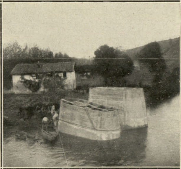
Operación de colocar los cajones de cemento armado para la construcción de un puente sobre el Urumea, con destino al servicio del nuevo ferrocarril.
