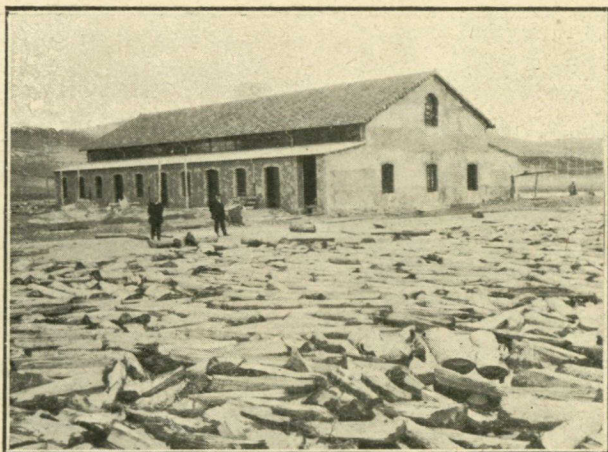
Depósito y aserradero de maderas.
