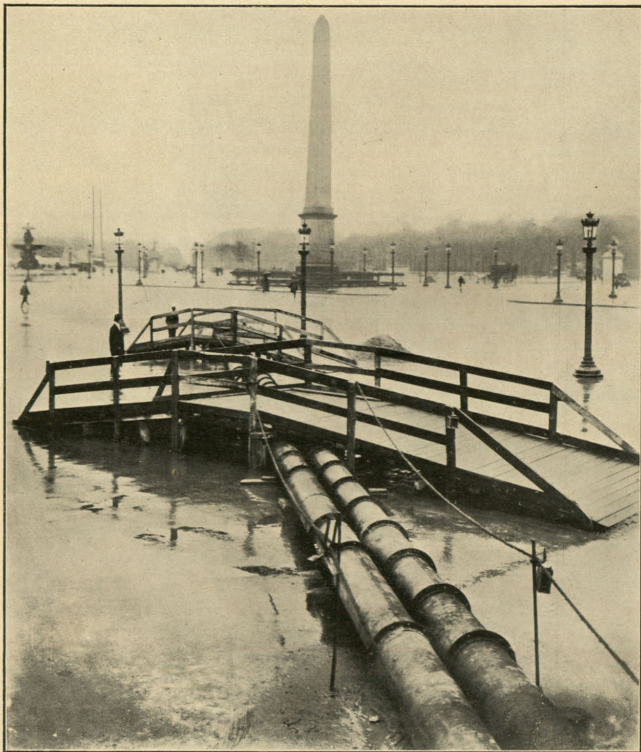
Pasarelas establecidas en la plaza de la Concordia de París, para facilitar el tránsito dificultado por las numerosas cañerías de desagüe instaladas después de la inundación.
