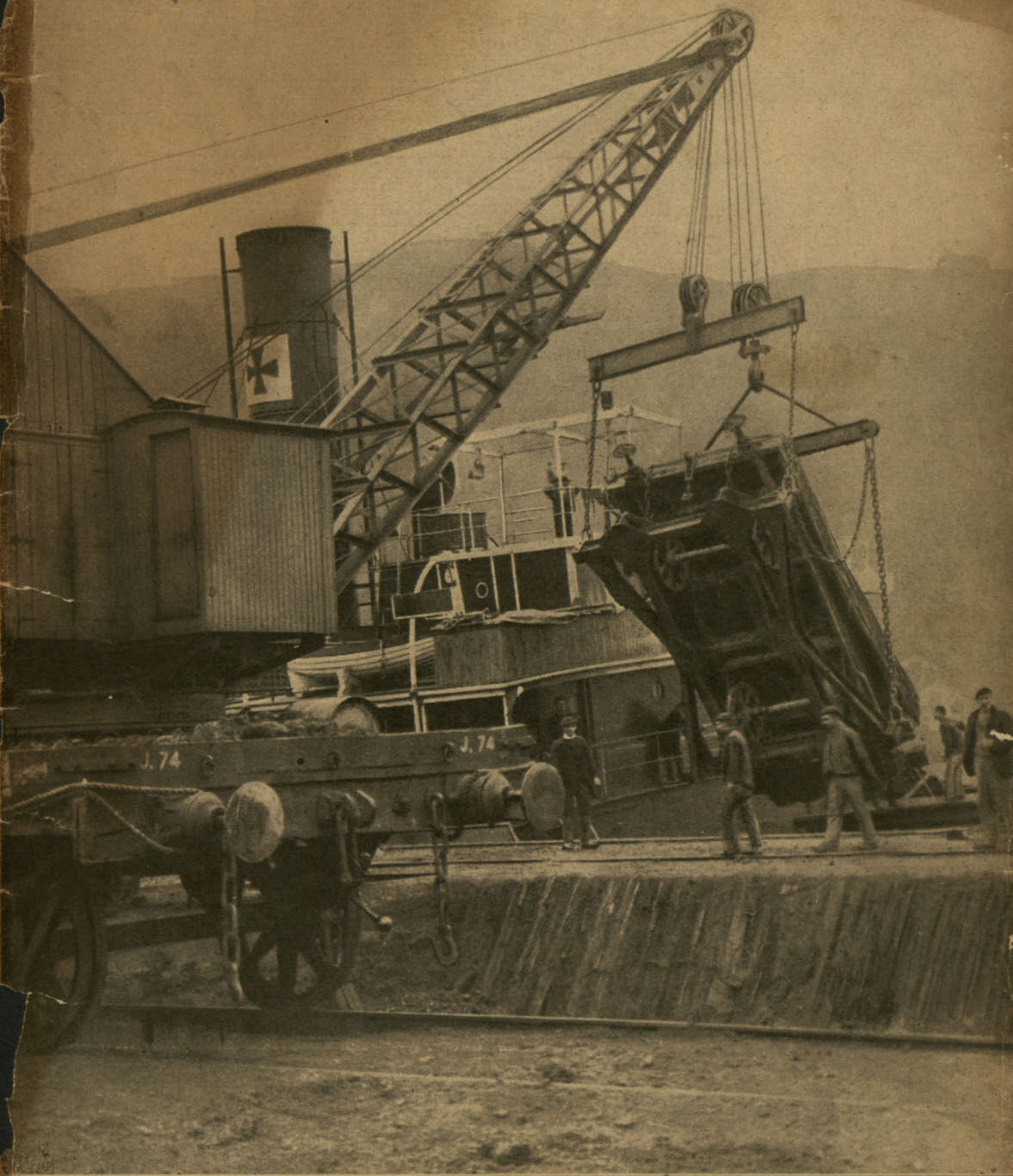
LA GRUA DE 300 TONELADAS DEL PUERTO DE PASAJES, DESCARGANDO VAGONES, POR URCABE
