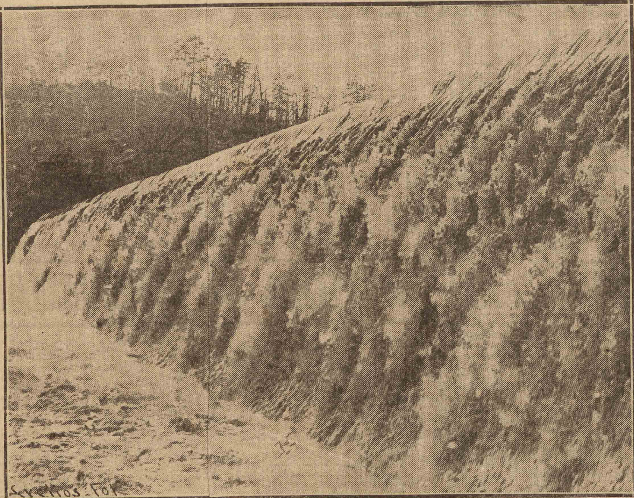
LAS AGUAS DEL RIO CHATTAHOOGIEC (ROSWELL), CUYO NIVEL SE HA VISTO AUMENTADO CONSIDERABLEMENTE T CAUSA DEL DERRETIMIENTO DEL HIELO, SE VIERTEN SOBRE EL DIQUE EN BULL SLUICE.
