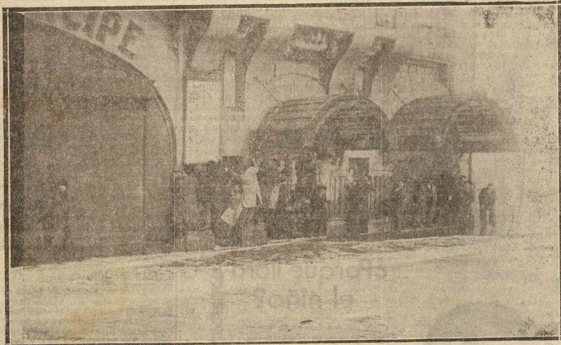
Calle convertida en río. El mar intruso vierte toneladas de agua, que invaden la ciudad en corriente impetuosa, que derriba a la gente como para recrearse en el susto del caído que rueda envuelto en la riada callejera. Otros se escapan en un chapoteo que causa risa; otros huyen en un trepar angustiado, bajo el efecto de una emoción que sólo es comparable a la que sentían en años lejanos aquellos que escapaban del "soka-muturra" y creían sentir el aliento del bucy cercano...
