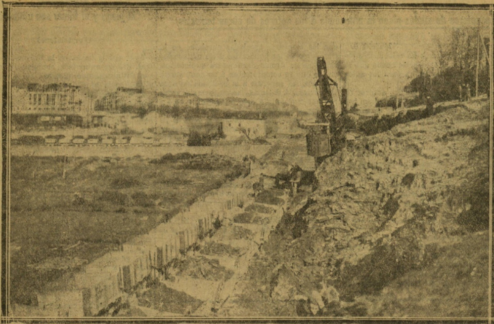
Estado actual de las obras de encauzamiento del Uruméa. (Foto Lecuona.)
