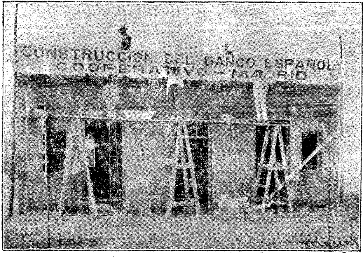
CONSTRUCCION DEL BANCO ESPAÑOL COOPERATIVO - MADRID
