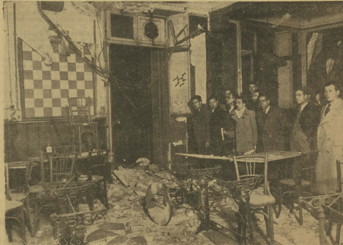
Daños causados por una granada en el Salón - Café.
