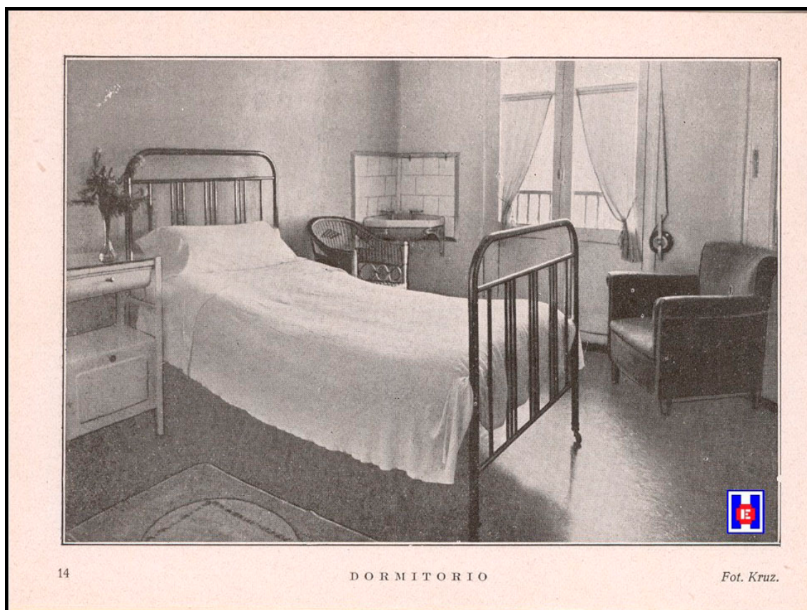
Foto 10 Habitación individual. Cuaderno de fotos de la Clínica Operatoria San Antonio. Fotos: Kruz. 1928
