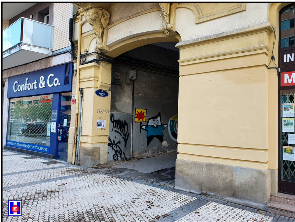
Foto 47 En la calle Duque de Mandas de Egia de San Sebastián, entre los números 21 y 23 está el túnel llamado “Maldatxo Kalea” por donde subían en 1928 los carruajes de caballos y posteriormente los taxis y coches para ir a la Clínica Operatoria San Antonio. Foto 2020
