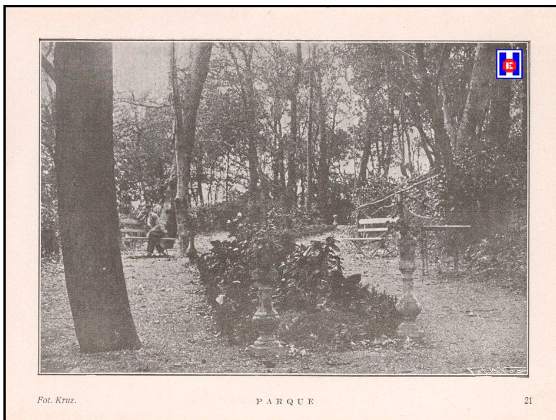
Foto 5 Parque lleno de árboles y de macizos floridos rodea el edificio. Cuaderno de fotos de la Clínica Operatoria San Antonio. Fotos: Kruz. 1928
