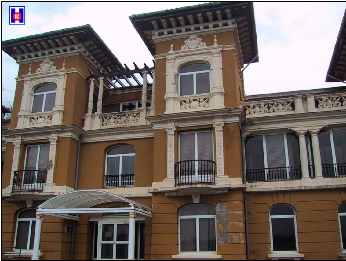
Foto 46 OSALAN. Fotografía realizada por Manuel Solórzano Sánchez. 2006
