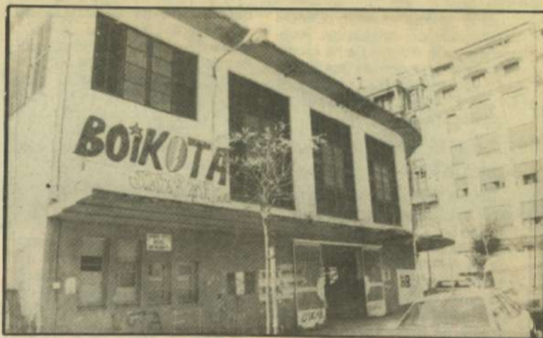
El mercado será derribado para reurbanizar la zona. (Foto Postigo)
