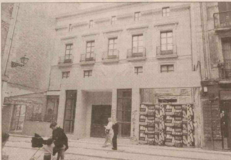
La entrada añadida en Esterlines al futuro ambulatorio rompe la estética del edificio, dice García Velilla. MICHELENA
