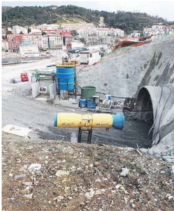
Obras del Metro en Alzaiz. MIKEL FRAILE
