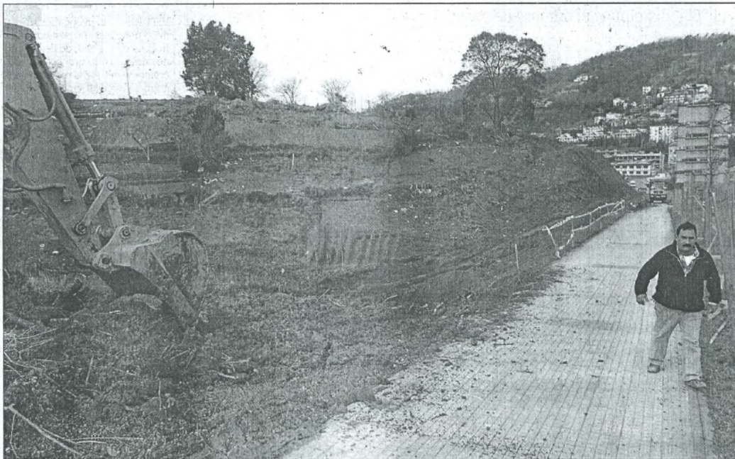
Un paseante atraviesa el camino de Marrutxipi, junto a las obras para la construcción de pisos protegidos de promoción municipal. / IÑIGO IBAÑEZ
