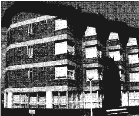
Edificio de la residencia para personas mayores de Zorroaga. POSTIGO
