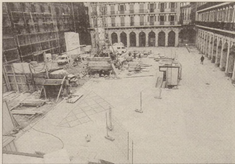
Se prevé que las obras de pavimentación y fachadas de la plaza estén acabadas para Santo Tomás. POSTIGO
