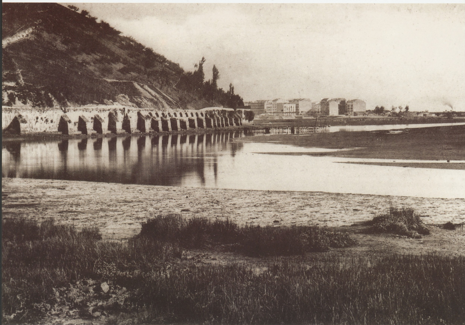
Aintzinako Osasun Iturriaren pasealekua, gaur Amara auzoa, 1870. Antiguo paseo de la Fuente de la Salud, hoy barrio de Amara, 1870.
