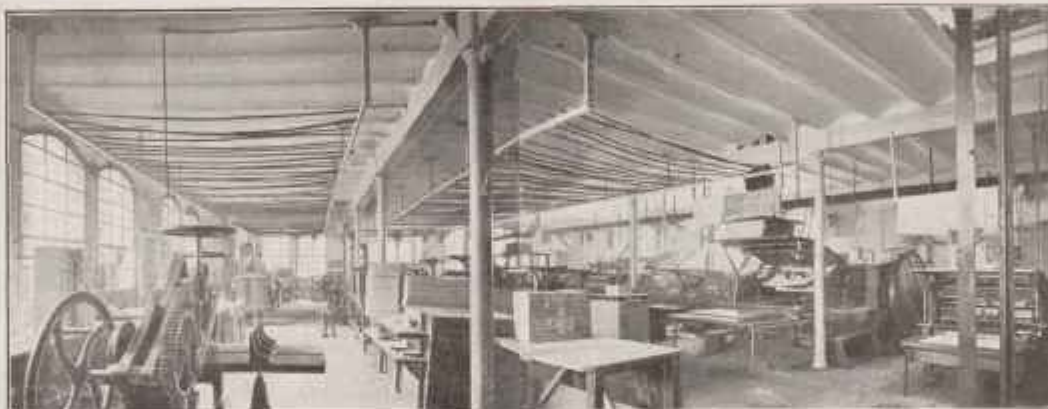
SALA DE MÁQUINAS
