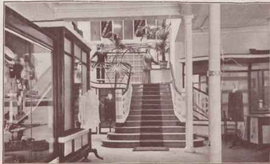
Vista de una parte del local, con la escalera de acceso al piso superior.
