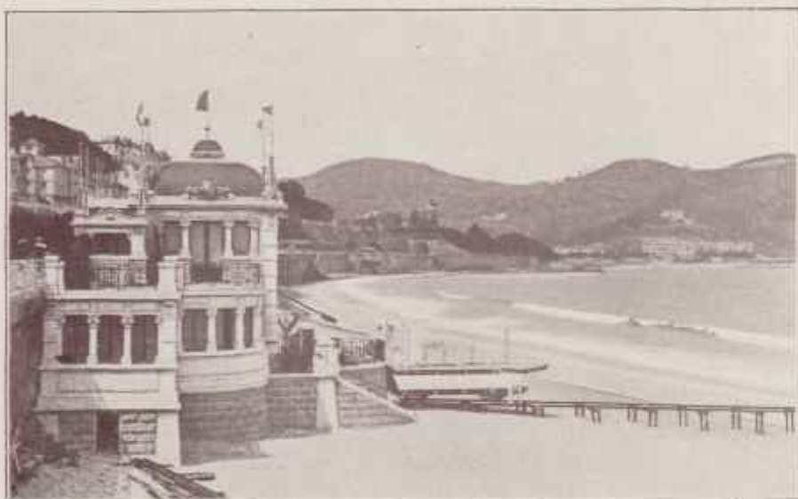
Caseta Real de Baño
