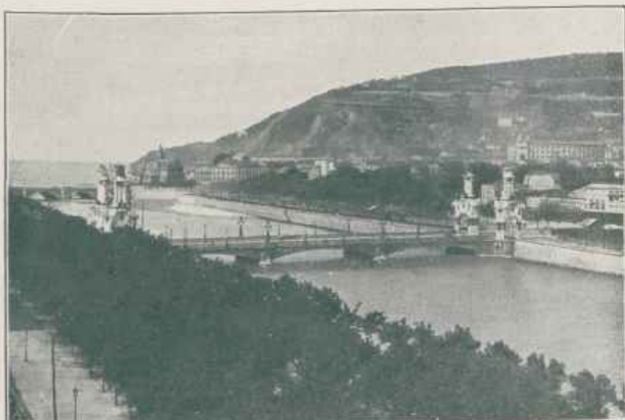
Vista de los puentes sobre el Urumea y Paseo de los Fueros
