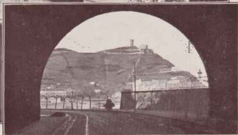
Vista del Monte Igeldo a la salida del túnel
