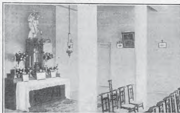
Vista parcial de la capilla.
