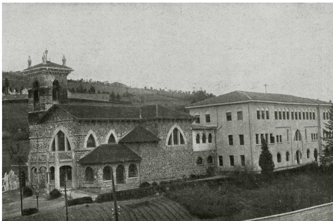
Noviciado de Zumarraga, Gipuzkoa
