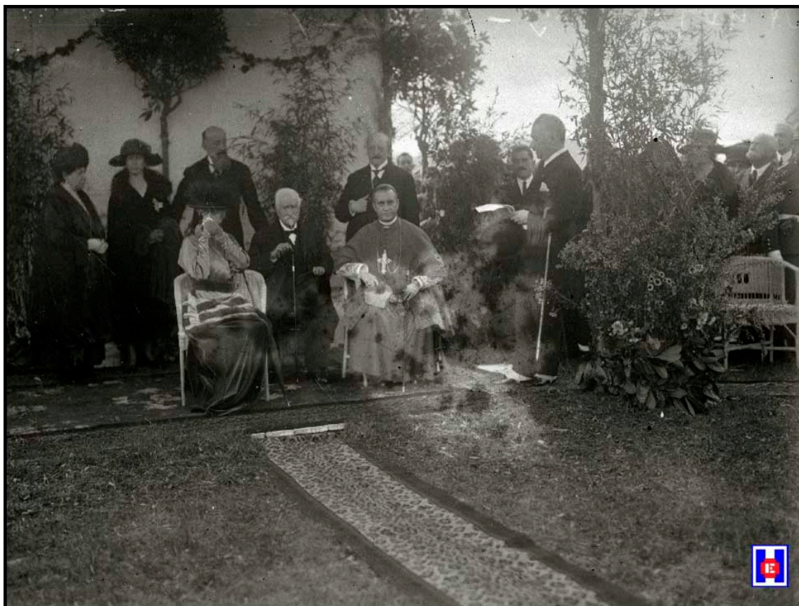
Foto 11 La Reina María Cristina en el acto de colocación de la primera piedra del Hospital Goyeneche, con Monseñor Leopoldo Eijo Garay, Conde de Guaqui. Pedro Zaragüeta Aristizabal, Alcalde de San Sebastián y Presidente de la Caja de Ahorros Municipal y el Príncipe Pío Saboya, Mayordomo Mayor de la Reina. Foto Ricardo Martín
