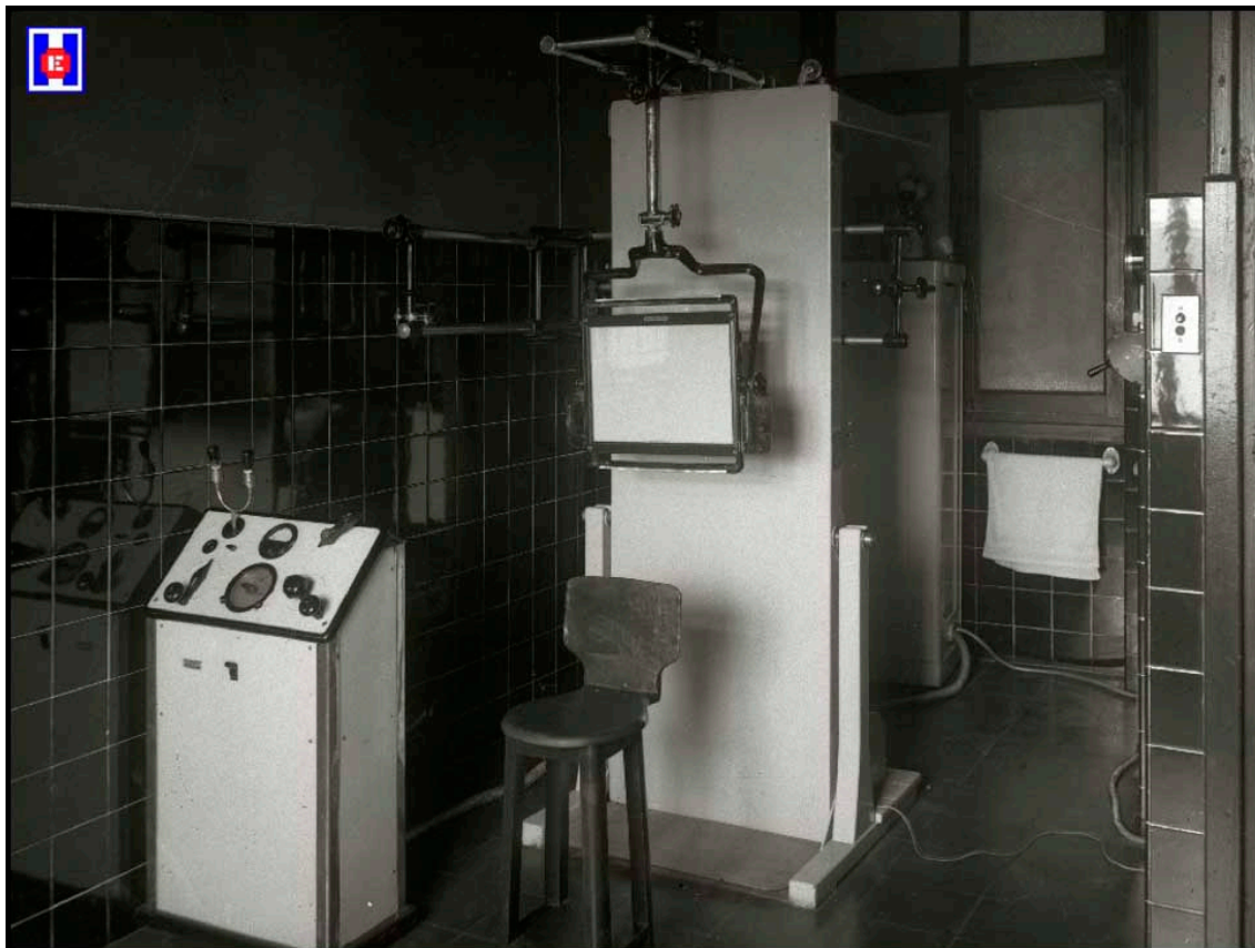
Foto 11 Sala de Rayos X del Dispensario Antituberculoso
