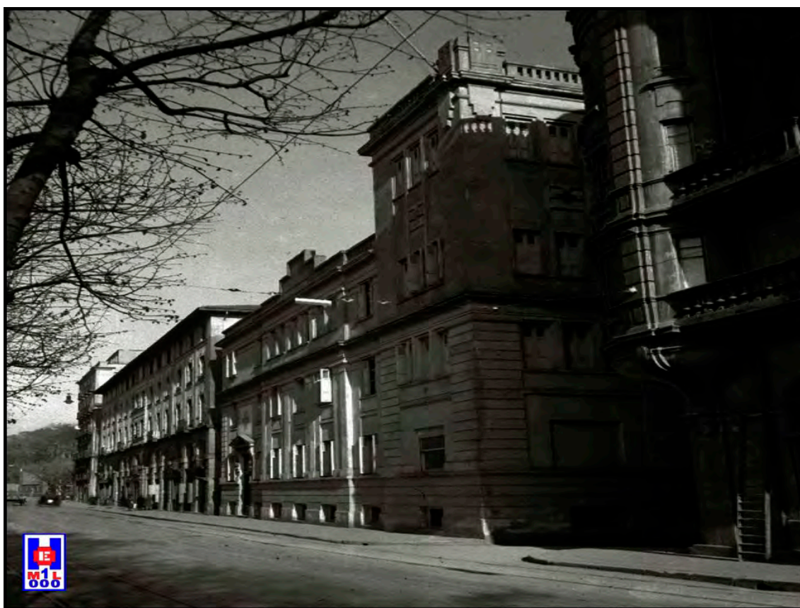
Foto 22 El nuevo Hospital de la Cruz Roja de San Sebastián en la calle Matía nº 7
