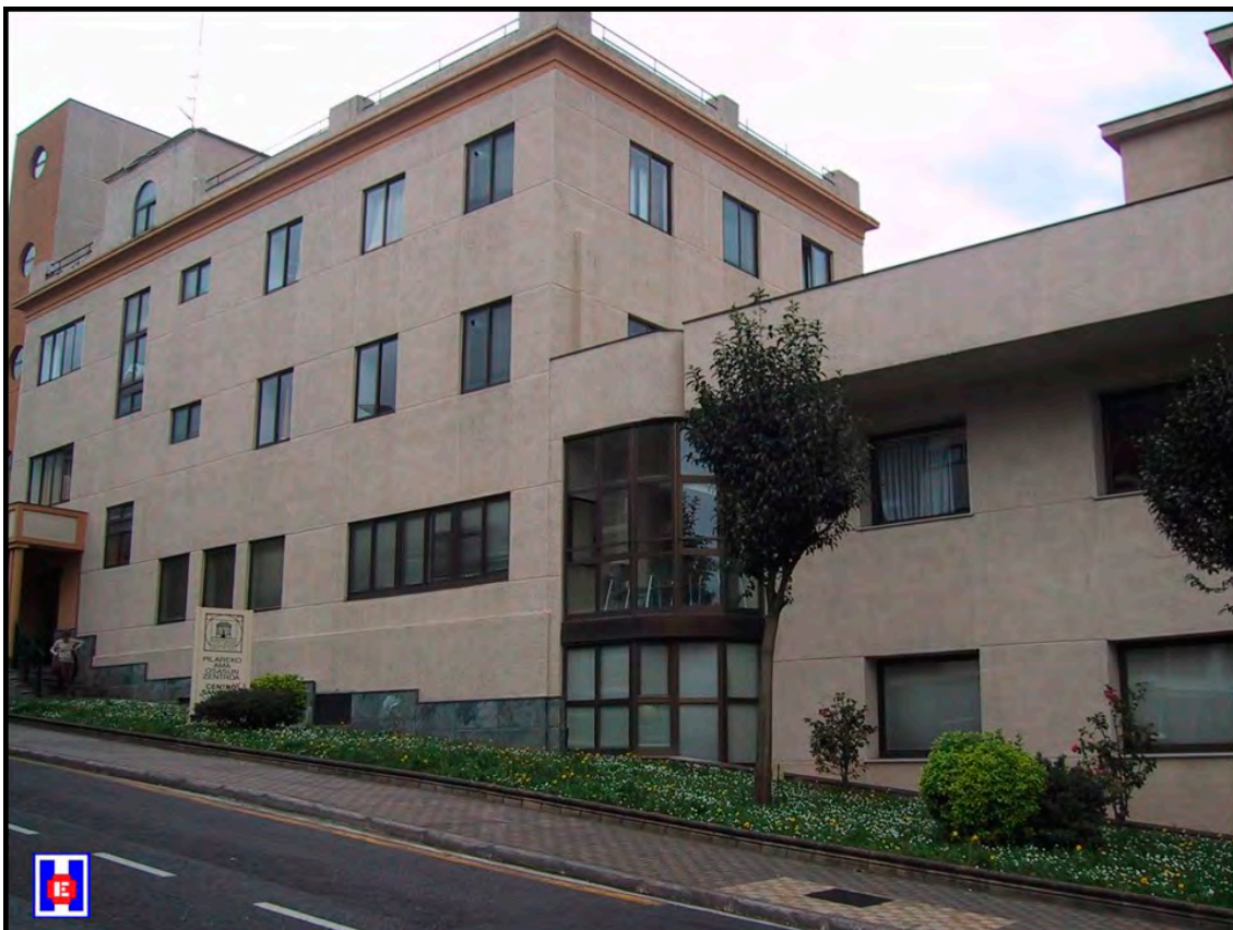
Foto 66 El edificio que albergaba el Centro Sanitario Virgen del Pilar cierra, en el paseo de Zarategi, será derribado
