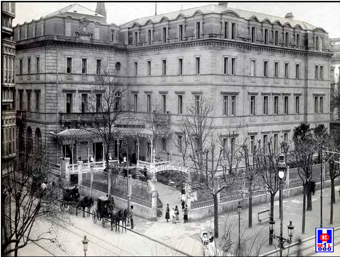
Foto 2 Hotel du Palais, en la Avenida de La Libertad, esquina con la calle Guetaria. 1903
